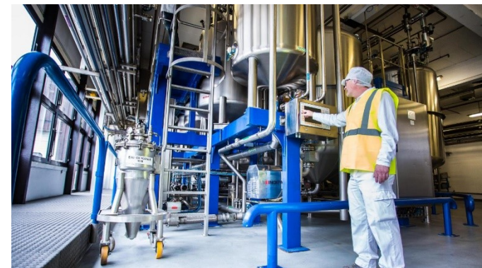
L'Oréal (Libramont) Installation d'un évapoconcentrateur
