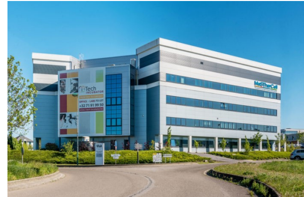
MaSTherCell (Gosselies) Nouvelles installations pour des salles blanches et laboratoires
