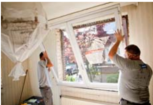
Demontage d'une fenêtre PVC installée il y a 45 ans. La première fenêtre PVC installée en Région Bruxelloise.
