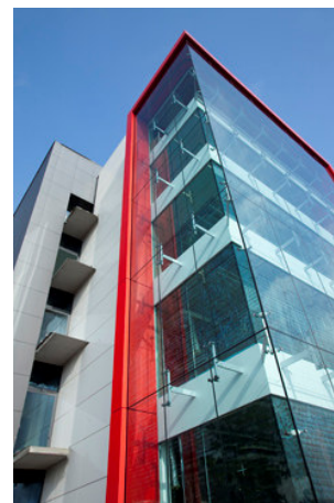
Soudal – Turnhout Nouveau centre R&D 10 mio €
