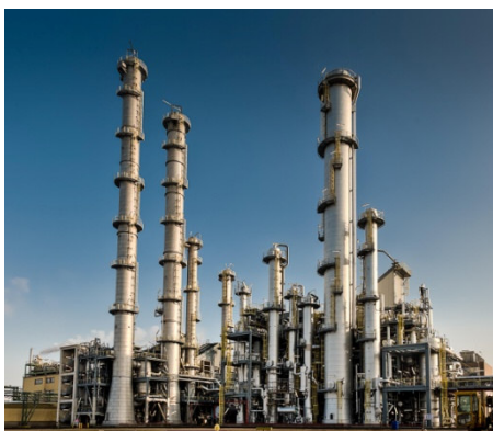
Evonik – Anvers Nouvelle installation isobutène 40 mio €
